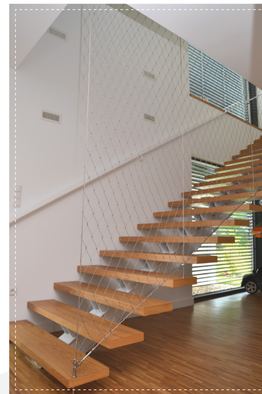
Zabezpieczenie schodów - siatka rozpięta na linach konturowych
