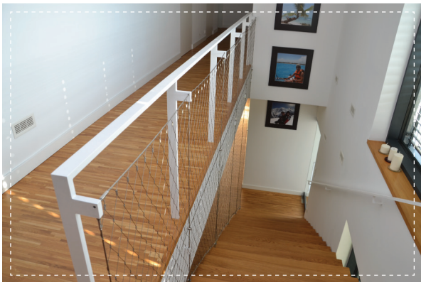
Zabezpieczenie siatką w połączeniu z balustradą
