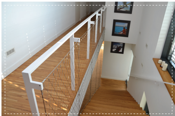
Zabezpieczenie siatką w połączeniu z balustradą
