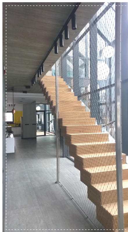
Zabezpieczenie biegu schodów - siatka rozpięta na linach konturowych mocowanych do profili
