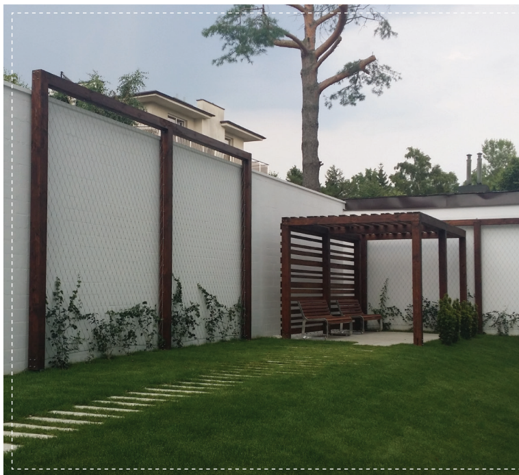
Zielona ściana z wykorzystaniem siatki mocowanej w drewnianych ramach
