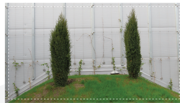
Konstrukcje linowe do prowadzenia roślin pozwalają na wprowadzenie dodatkowej zieleni i poprawienie estetyki ściany
